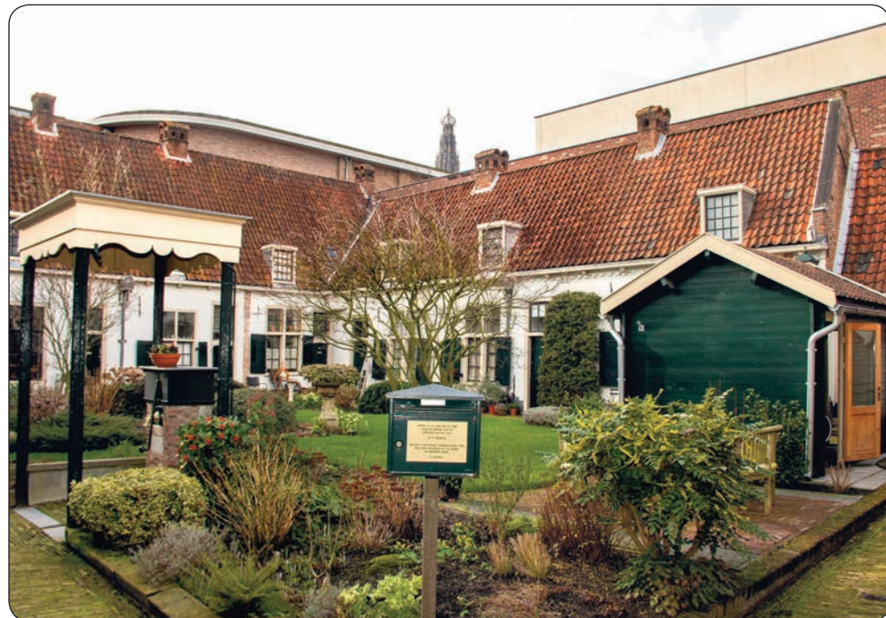
> De bakstenen muur, net te zien boven het dak aan de westzijde, zou in het oude plan anderhalf meter hoger zijn geweest
