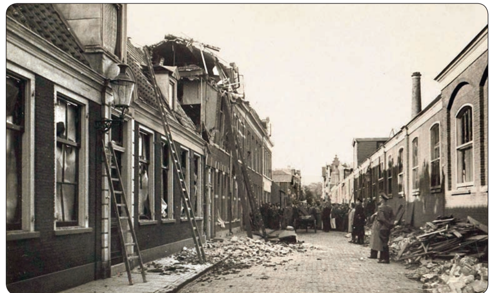
> Lange Molenstraat (achterzijde van beide hofjes) na de bominslag op 13 oktober 1941. De twee ladders links staan tegen de huisjes van het Hofje van Beresteyn. De derde ladder tegen 42a, het huis dat de voltreffer kreeg.
