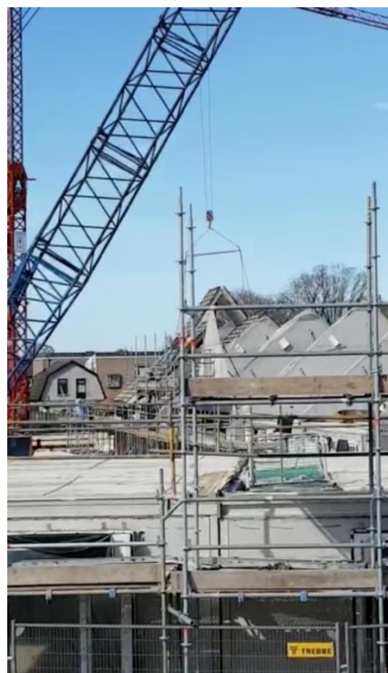
3 weken na start bouw in Hardenberg
